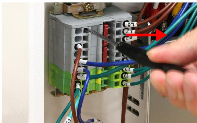
左上の結束バンドを切断し、固定されているケーブルをドライバに差し込みます。
